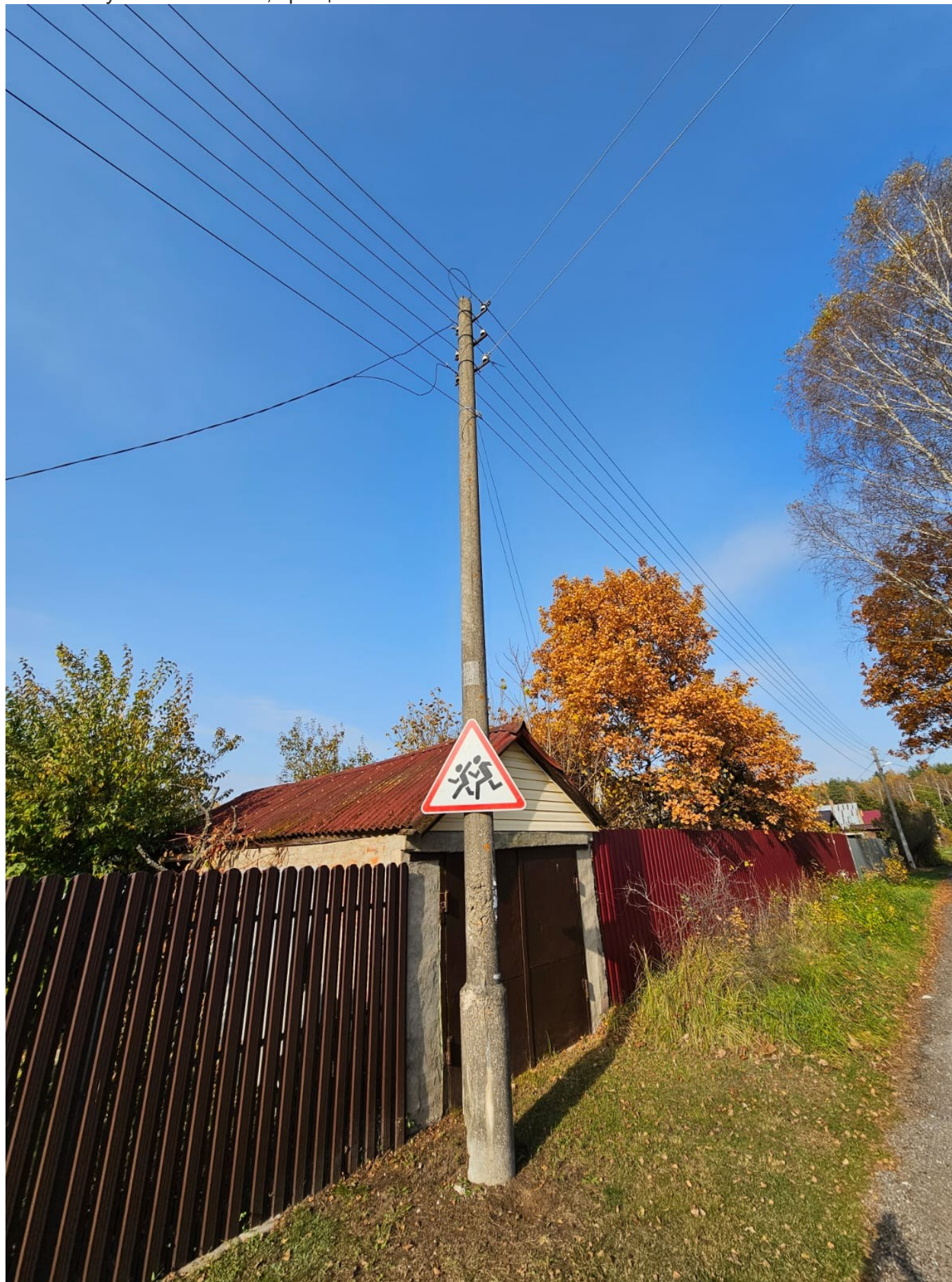
Столб 21 уч 47. Выбоины, трещины
