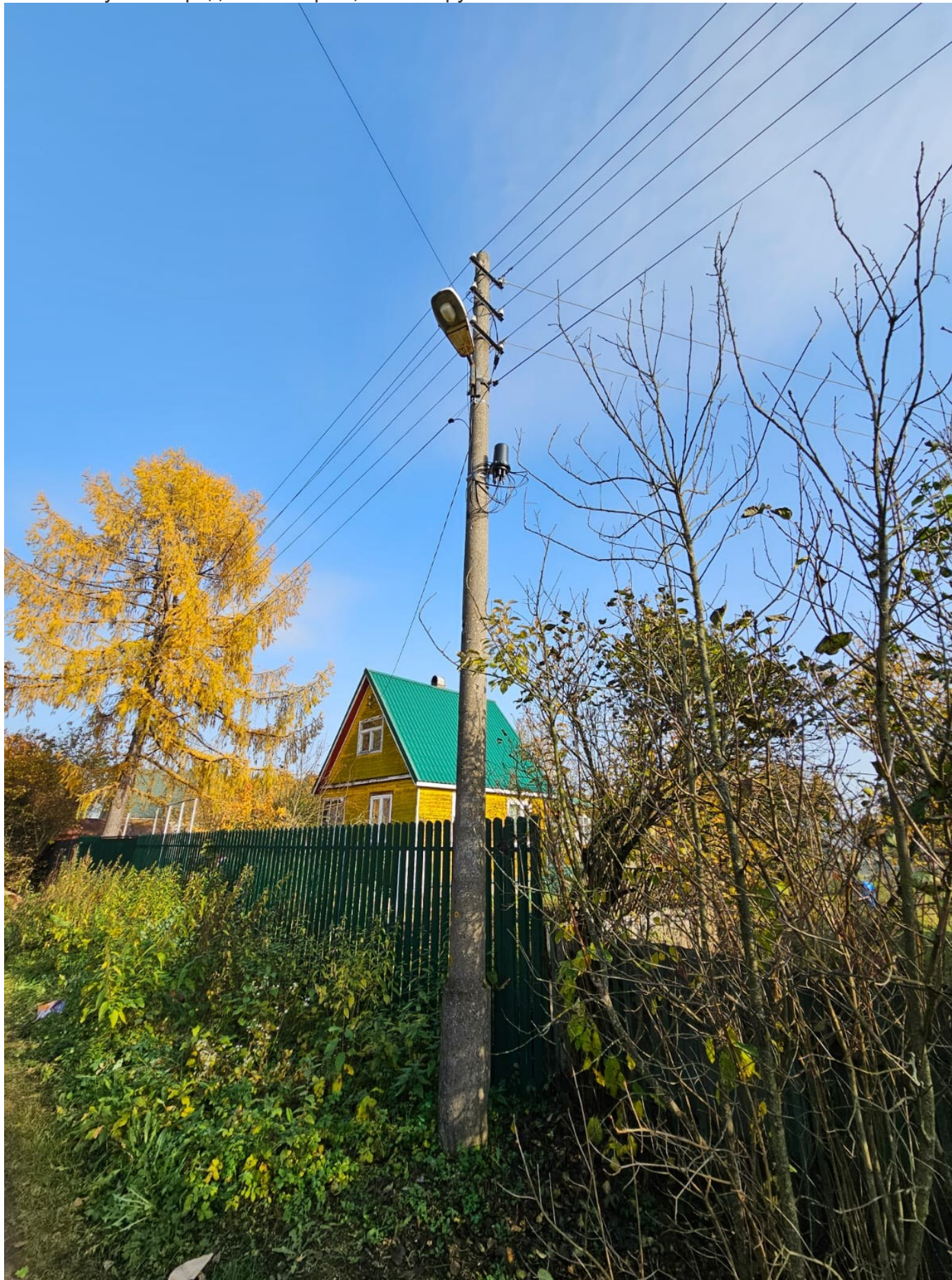
Столб 28 уч 37. Продольные трещины. Разрушение столба. Отклонение от оси
