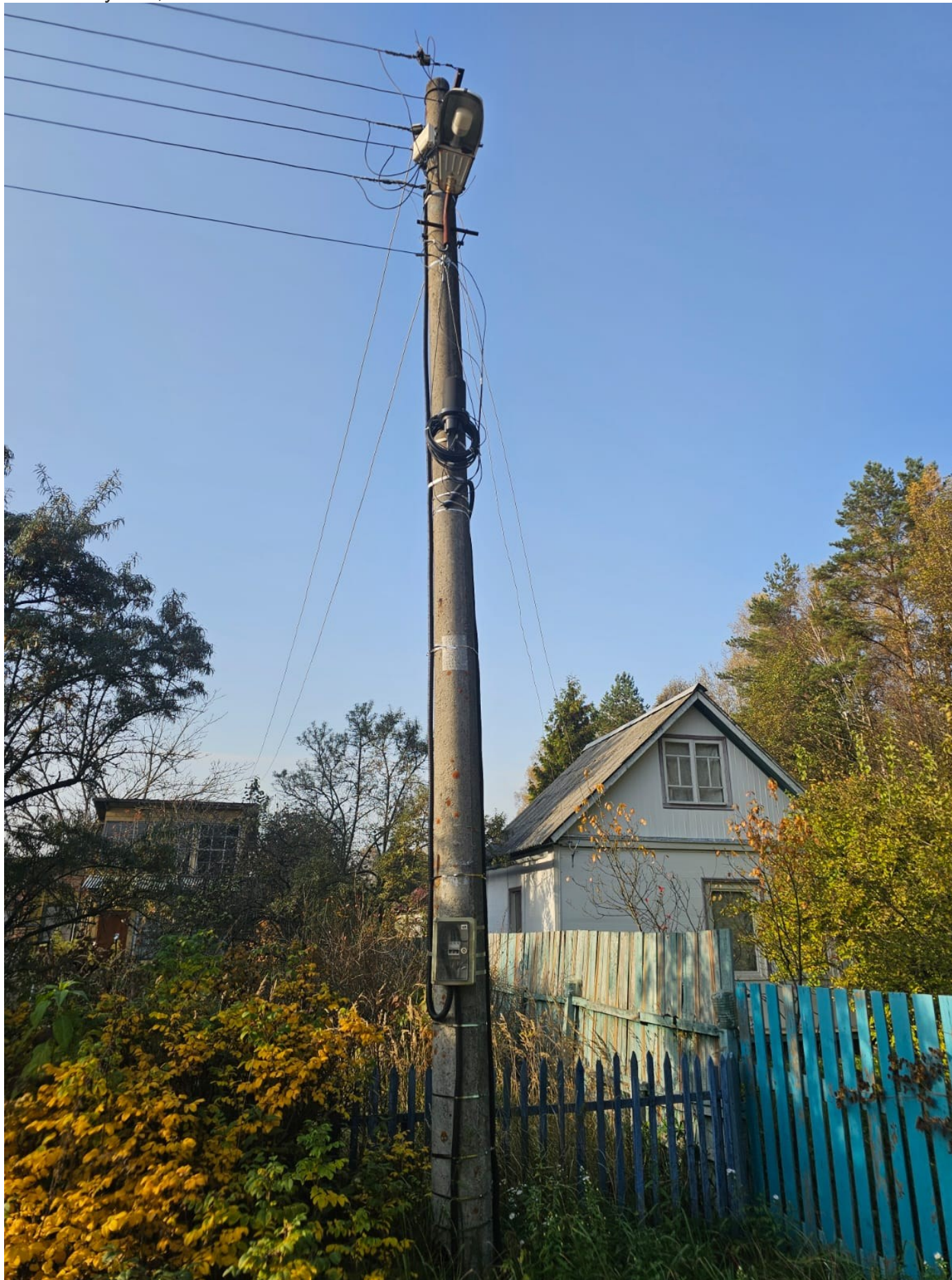
Столб 16 уч 67, отклонение от оси
