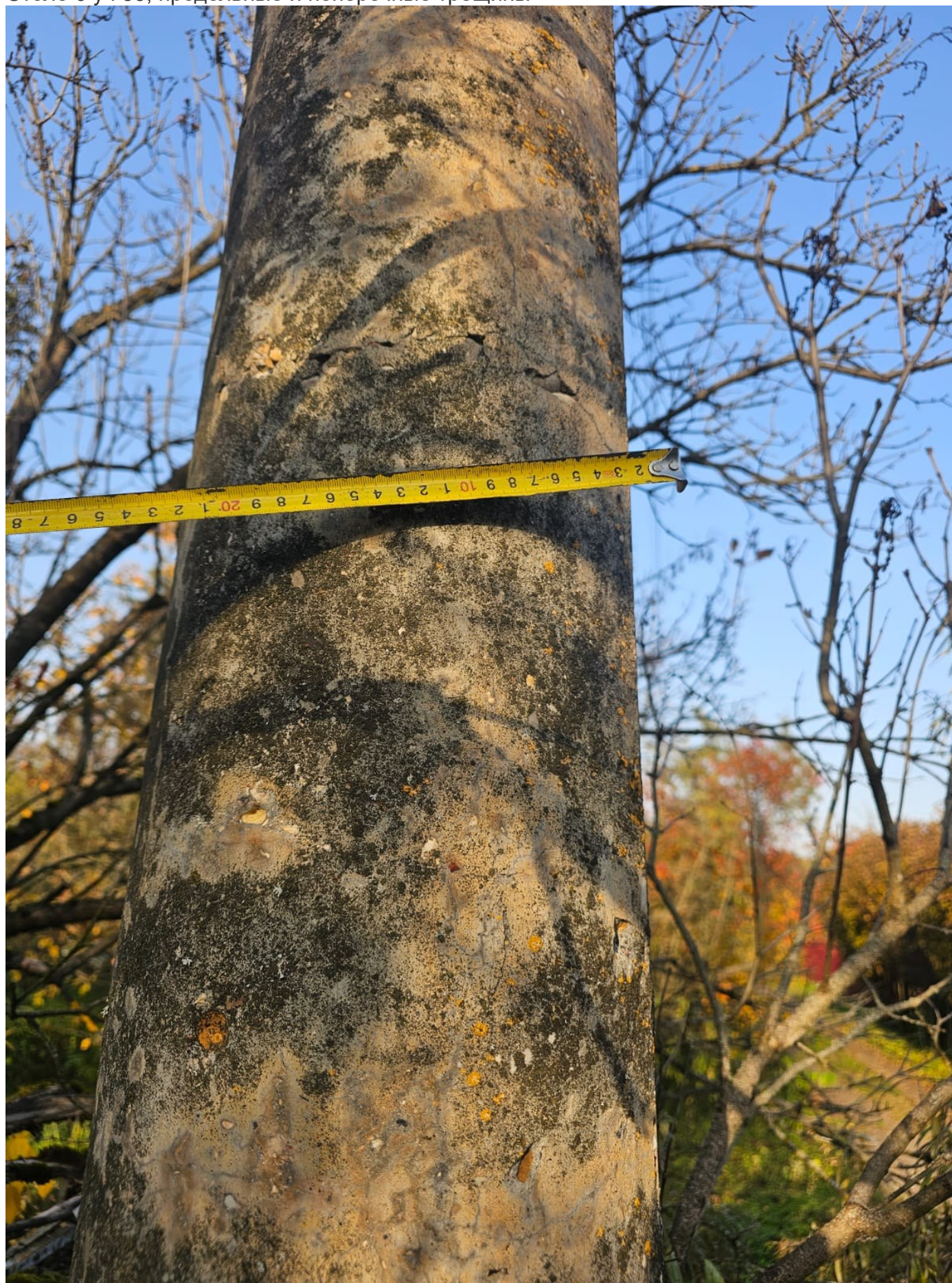
Столб 6 уч 85, продольные и поперечные трещины
