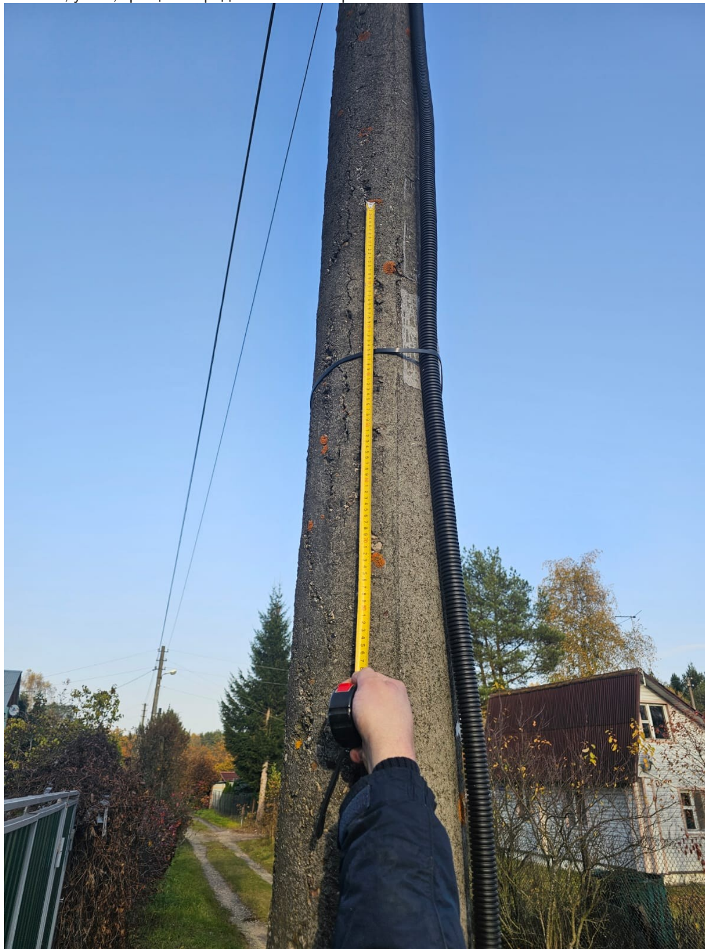
Столб 4, уч 88, трещины продольные и поперечные
