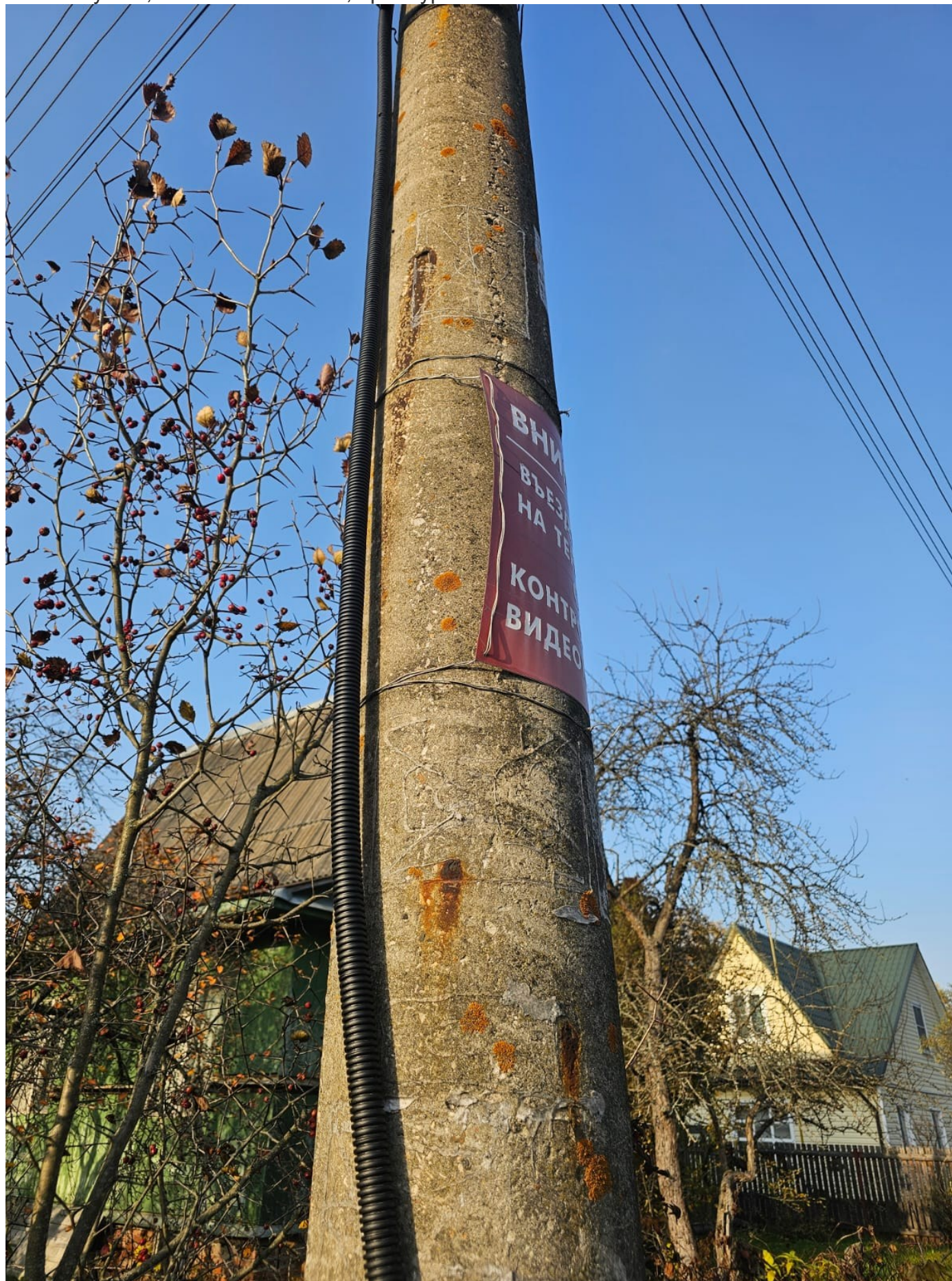
Столб 8 уч 81, отклонение от оси, арматура
