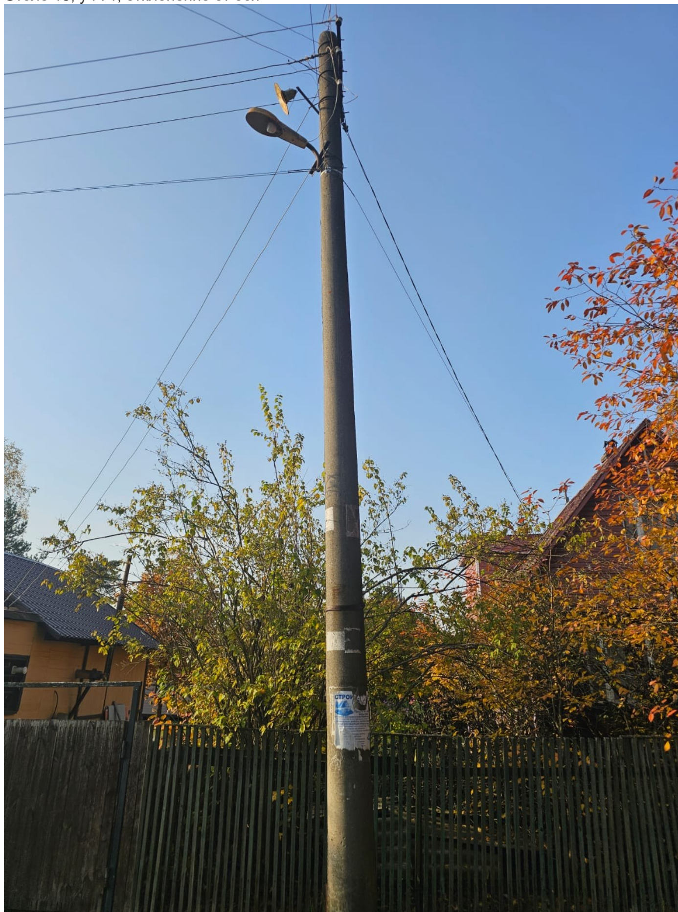
Столб 15, уч 71, отклонение от оси
